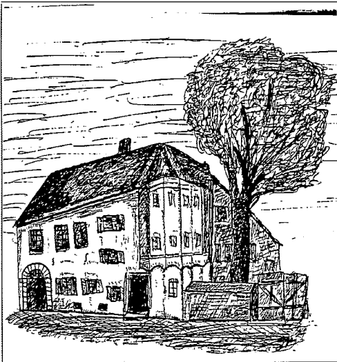
Mit zu dem ältesten Teil unserer Stadt gehört die Krämerstraße. 1808 wurde die linke Seite niedergelegt.
